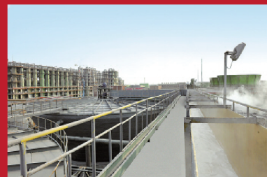
浓海水综合利用制碱工程
