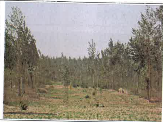
管道沿线恢复情况
